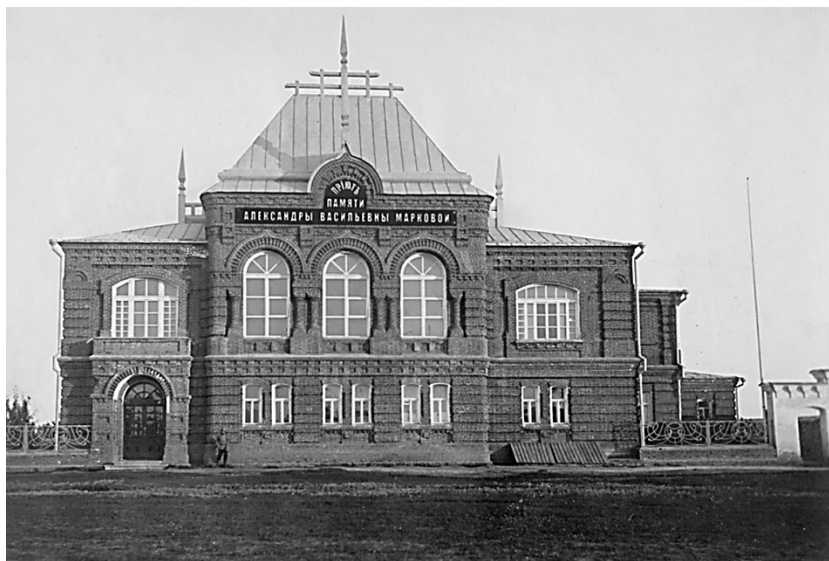
Здание сиротского приюта, построенного в 1903 году Фёдором Григорьевичем Марковым в память о своей жене Александре Васильевне (с 1978 года - здание краеведческого музея)
