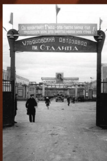
Проходная завода УльЗИС. 1944 г.
