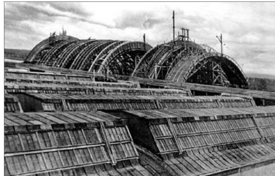
Таким мог бы быть авиазавод в г. Ульяновске. Завершение строительства авиационного завода, Комсомольск-на-Амуре, 1938 г.
